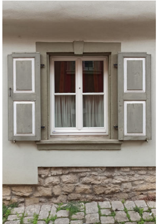
Fensterteilung, Gewände, Klappladen
