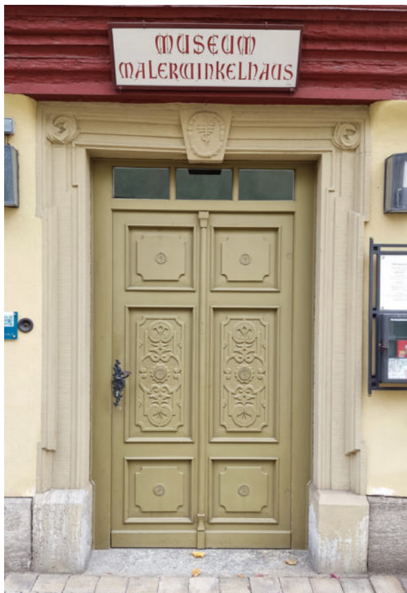
Kassetierte Tür mit Sandsteingewände
