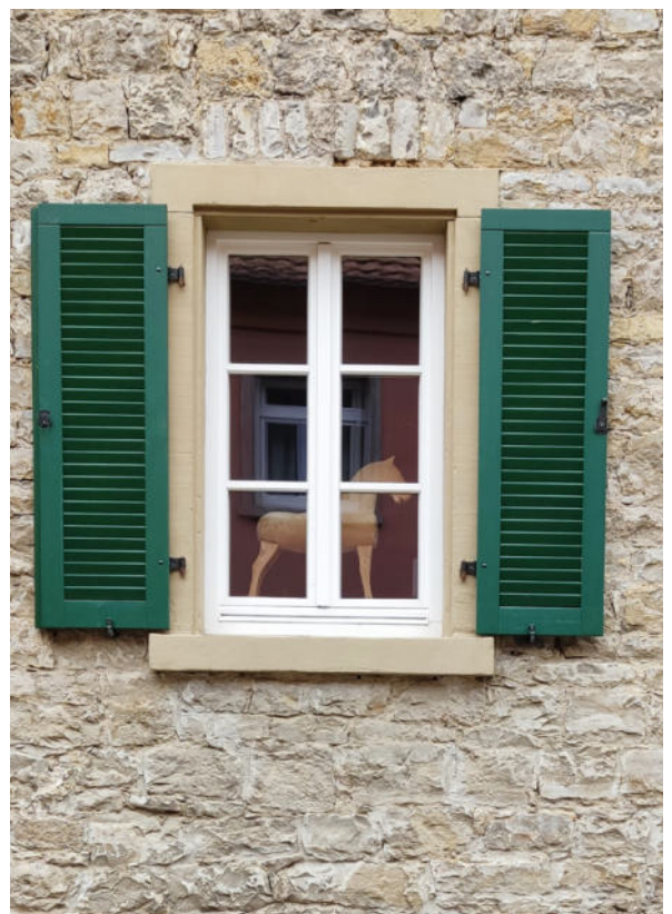
Fensterladen mit Lamellen
