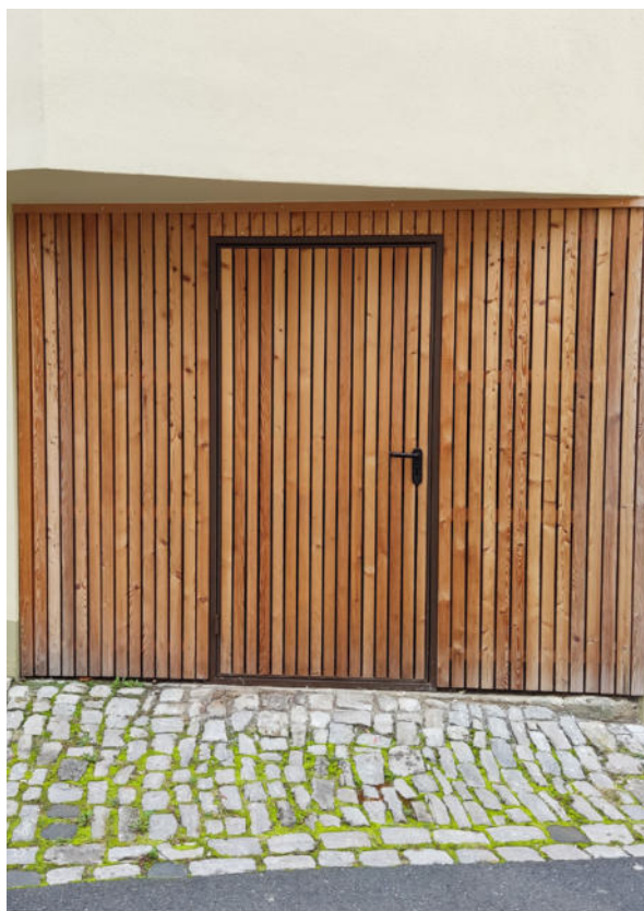
Tor mit integrierter Tür
