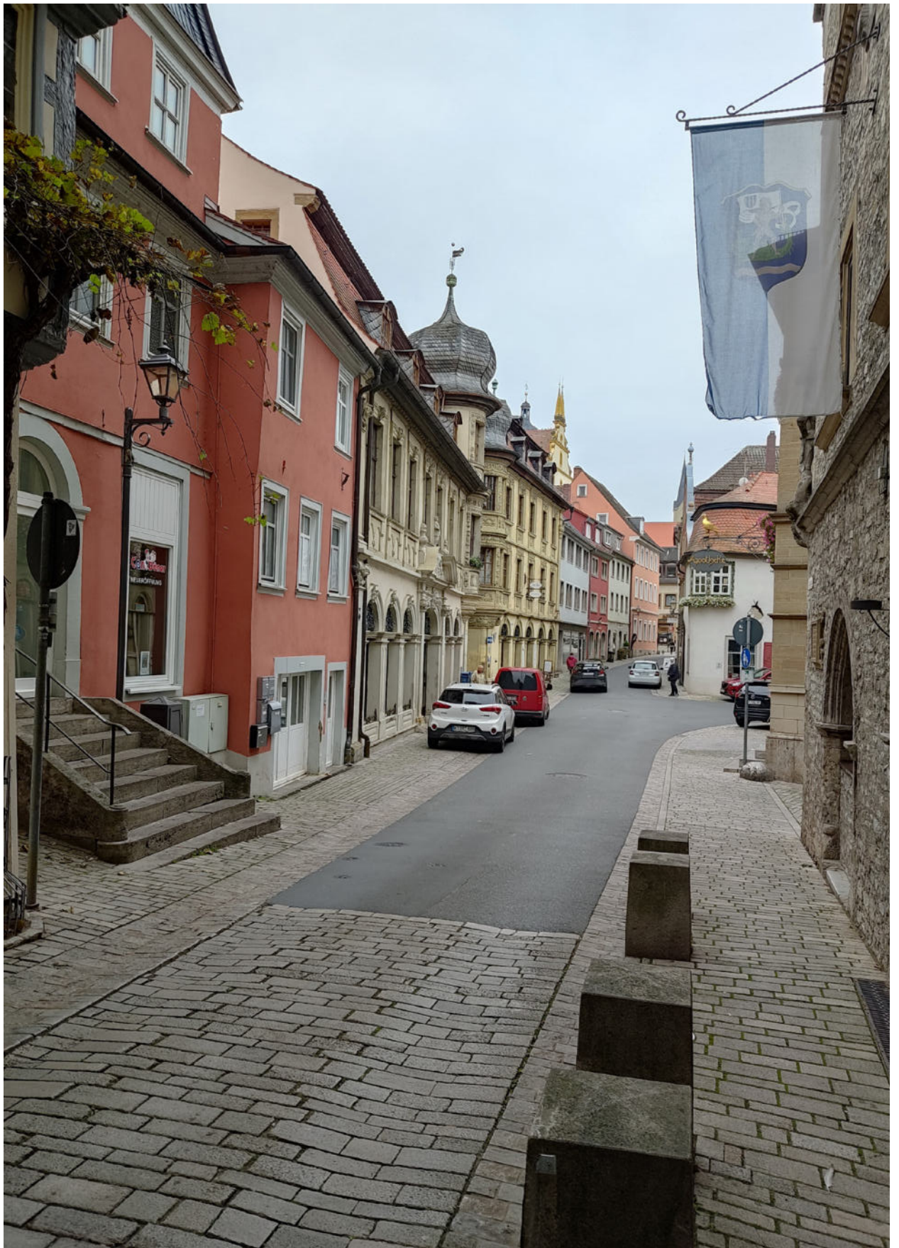
Altstadttypische Raumkante: Hauptgebäude direkt an der Straße
